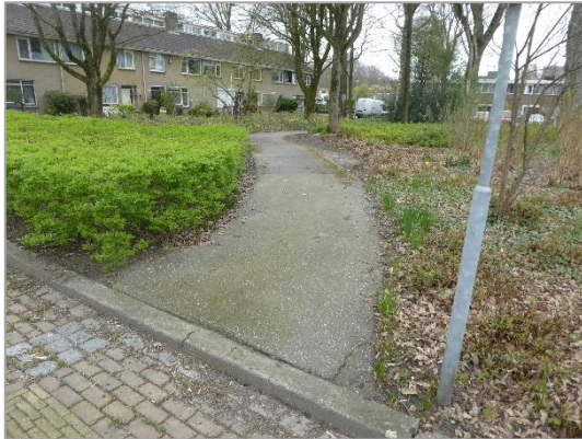
Foto 17: voetpad Kasteel Cannestraat, vanaf zuidzijde park
