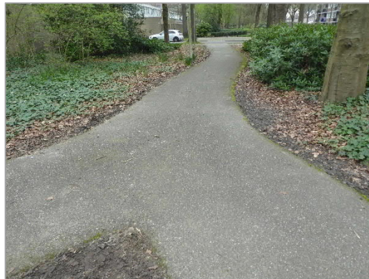
Foto 4: voetpad Kasteel Doorwerthstraat, kruising achter huisnr. 143 (foto richting noorden)
