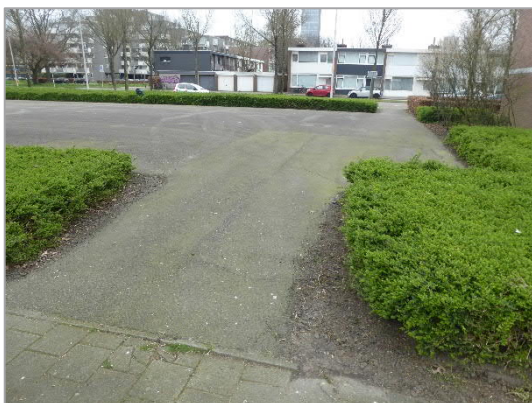
Foto 27: speelveld Kasteel Maurickstraat, vanaf zuidwestzijde speelveld (reparatie)
